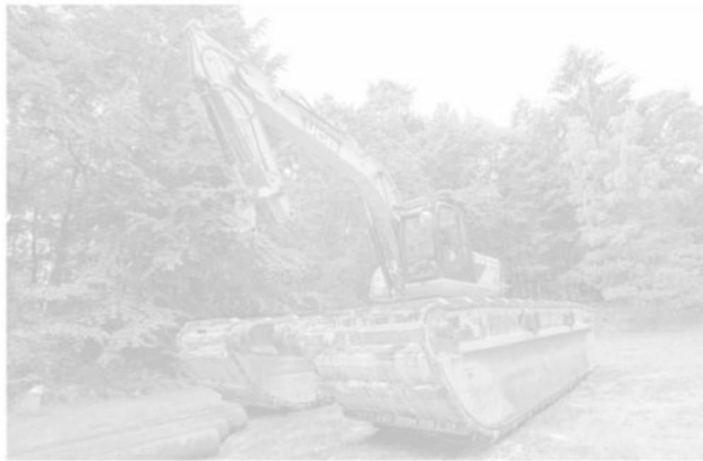
Dieser Schwimmbagger soll in den nächsten Tagen die Stahlrohre für die Schwimmer-Insel in den Boden des Klostersees rammen. Vorher müssen aber noch die alten Holzpfähle raus. FOTO: TORSTEN BENGELSDORF
